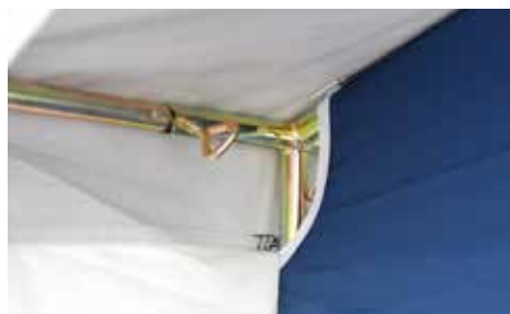
Struttura in acciaio
